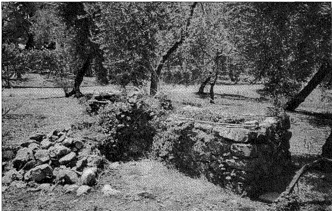
▲ Foto 2 Esterno del pozzo "D".
