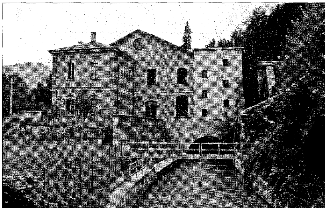
▲ Foto 6 Una piccola centrale idroelettrica.
