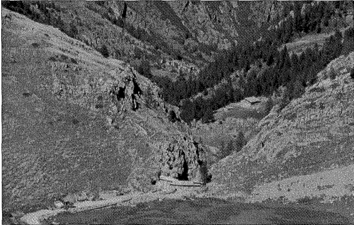
▲ Foto 11 Lavori di costruzione della presa al Colle del Preit.
