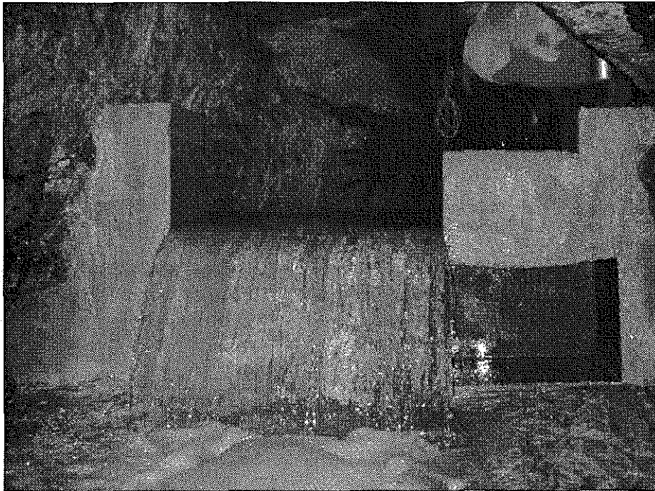
▲ Foto 2 Stramazzo costruito nella galleria principale.
