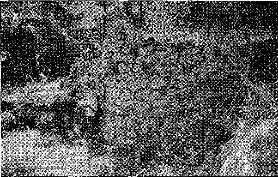
▲ Foto 1 Parete esterna di contenimento della cisterna "C".
